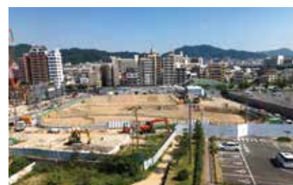
工事開始後まもない頃の現場
