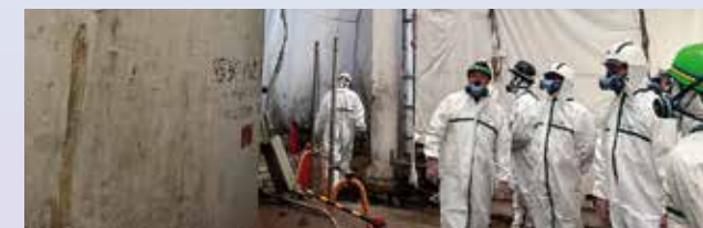
土木の解体現場パトロール
