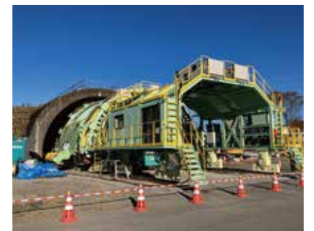
Reライニング工法 切削機外観
