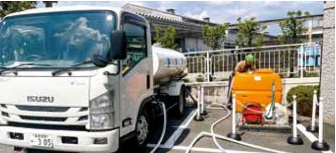
余剰水をバキューム車から散水用タンクへ
