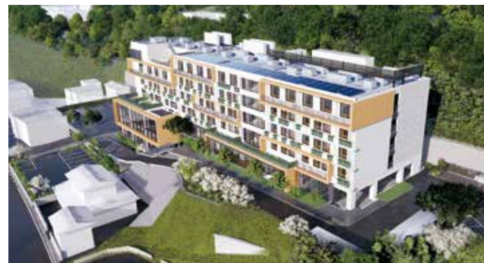
太陽光パネルを設置した屋上
