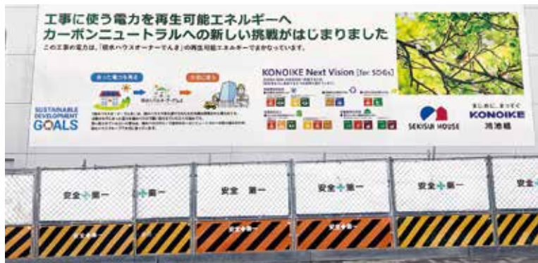
AKラインの現場で積水ハウスオーナーでんきを活用
