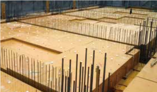
コンクリート床の下地用の型枠合板
