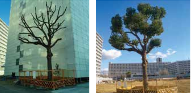
現場の樹木を撤去せず保護しながら施工
