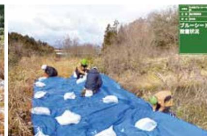
対策状況(ブルーシートによる堤体表面保護作業)
