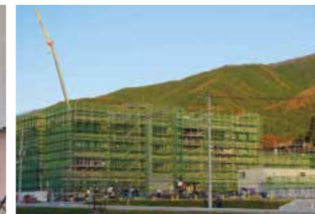
建築中の外観
