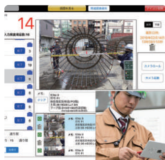
スマートデバイス：杭施工管理システム
