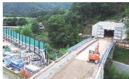
▲トンネル坑口付近全景
