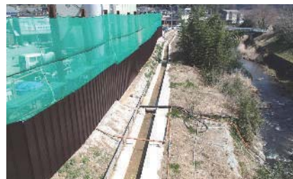
▲光無反射万能版・防塵ネット・土砂流出防止
