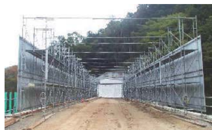
▲遮光用万能版(トンネル坑口河川橋梁部)
