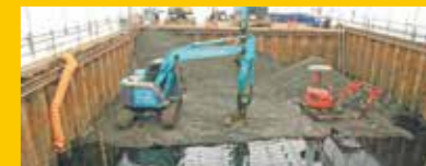
▲汚染源の掘削状況
