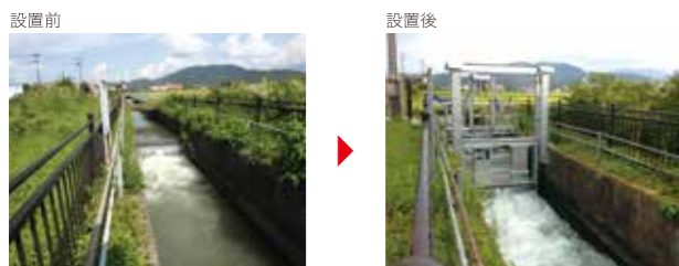
水土里ネット湖北-EBJ小水力発電所(滋賀県長浜市)
