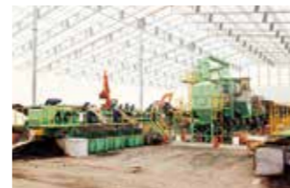
がれき類の中間処理
