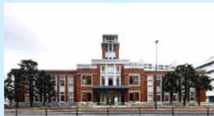
改修後の建物外観
