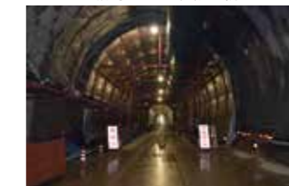
坑内覆工全景
