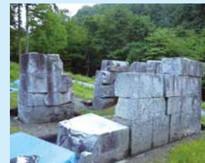
修復着手前 (積石の落下やズレ・割れがある)
