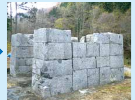
修復完了後 (積石は解体し洗浄補修後、組立)
