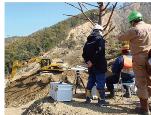
▲無人化施工状況
