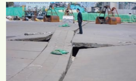
▲未施工の周辺部
