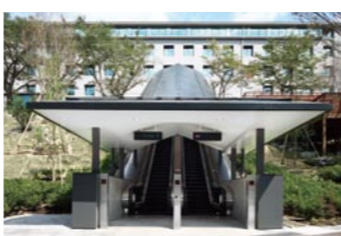
▲エスカレーター乗降口(8号館側)
