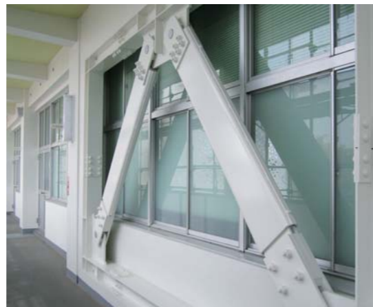
▲粘弾性ダンパーブレース(附属高校)
