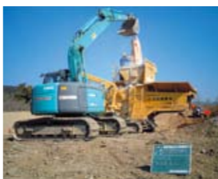
▲地盤改良リテラ機による改良土の作成
