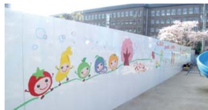
▲隣接する幼稚園の先生に絵を描いていただきました【(仮称)光華女子学園70周年記念棟新築工事】(京都府京都市)
