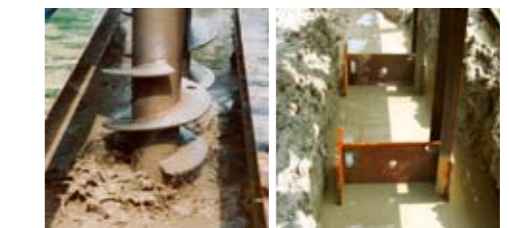
◀高流動化技術による施工状況
