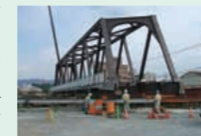
橋梁横引き状況
