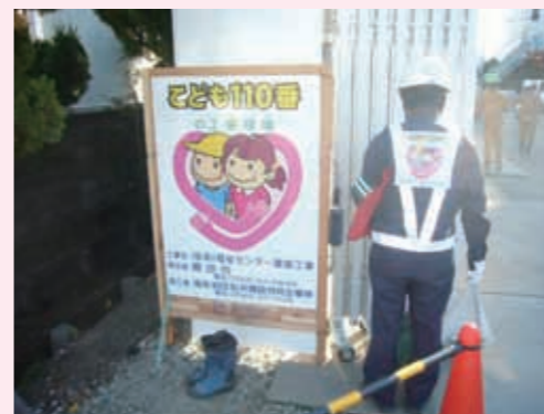
子ども110番工事事務所 (仮称) 福祉センター建築工事 (愛知県豊田市)
