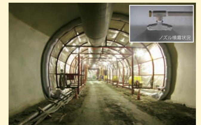
温度制御噴霧式養生システム 現場適用状況
