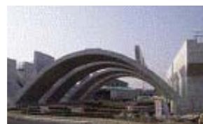
アーチ部完成
