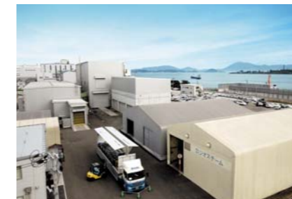
PCB汚染土壌処理施設
