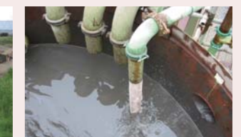
固化材スラリーの前添加状況
