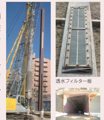
建て込み状況
