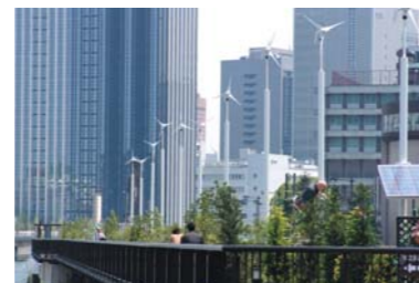
中之島新線イルミネーション用風力発電機
