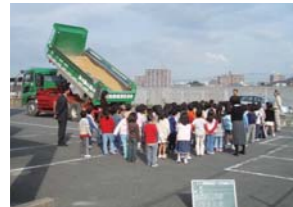
地元福岡南小学校生を招いての写生大会。福岡駅東整地工事(福岡県福岡市)
