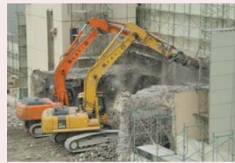
騒音源となる解体工事
