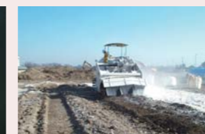
固化・不溶化処理状況
