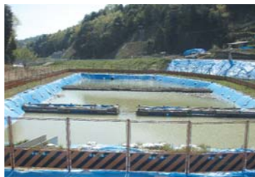
3層式の沈砂池
