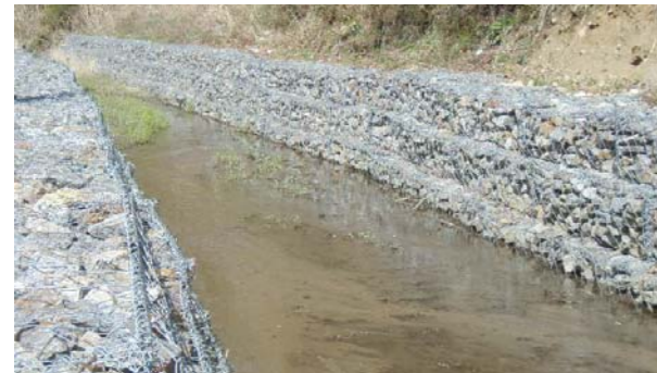
270mにもおよぶ付け替え水路
