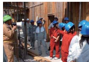
大阪建設業協会主催の「夏休み体験セミナー」現場見学会。兵庫中央病院病棟等建替整備工事(兵庫県三田市)
