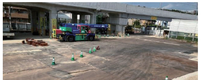
写真2 敷鉄板敷設完了
