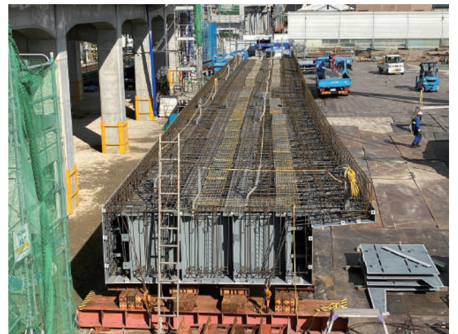
写真3 地組み部材全景
