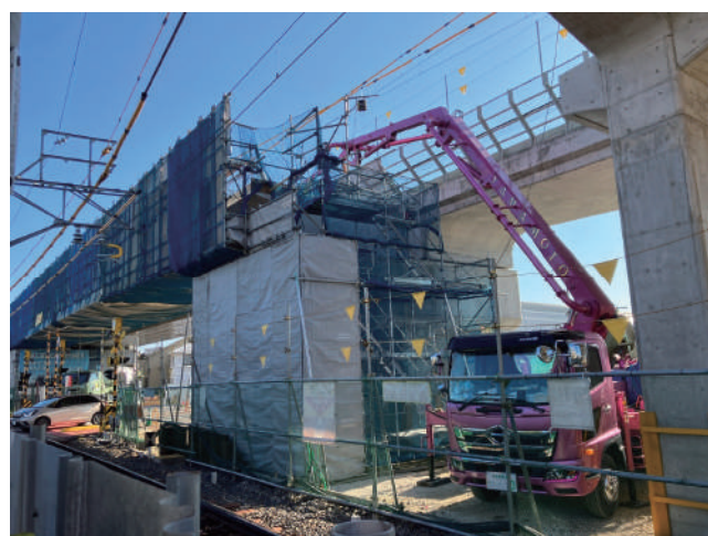
写真 7 コンクリート打設状況
