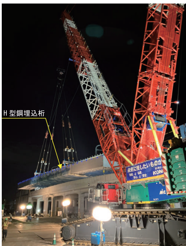
写真 5 H 型鋼埋込桁架設状況②
