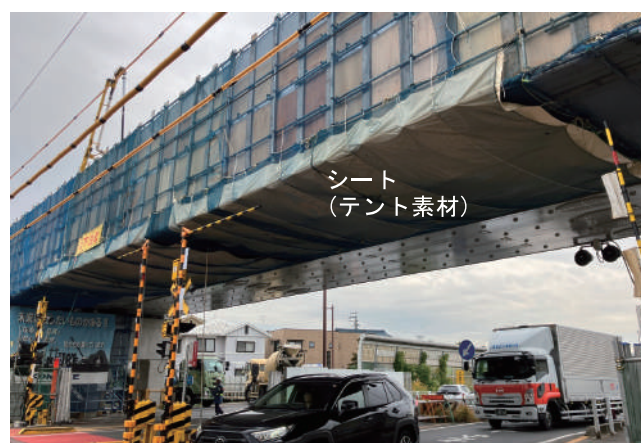
写真 8 水滴落下防止シート設置状況
