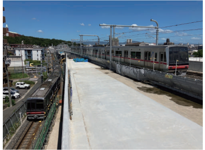
写真 9 現場全景（2 期施工完了）
