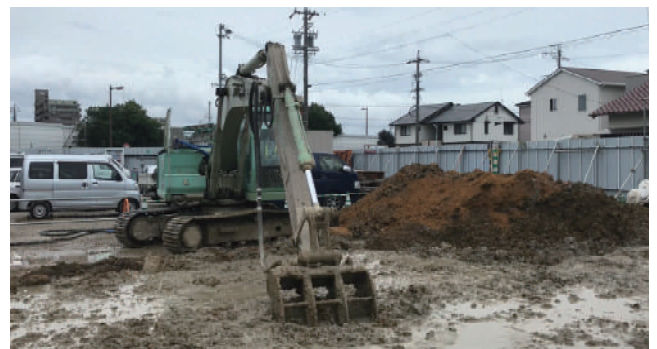
写真1 表層改良施工状況
