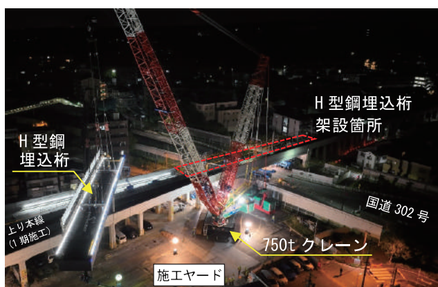
写真 4 H 型鋼埋込桁架設状況①
