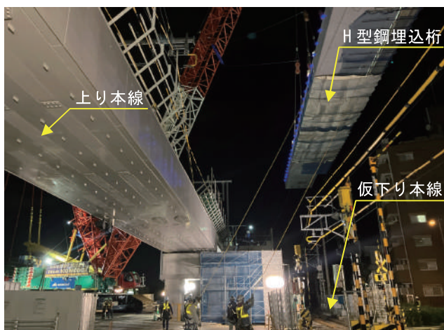
写真 6 H 型鋼埋込桁架設状況③
