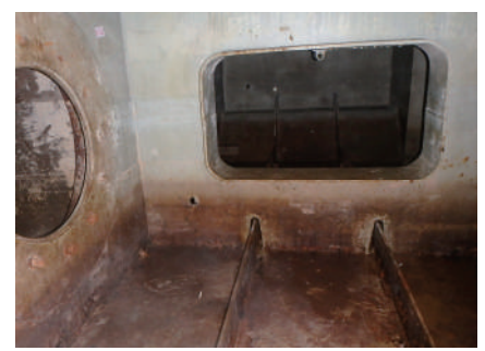
写真 6 PN-01 鋼製基礎内部防食工施工前
