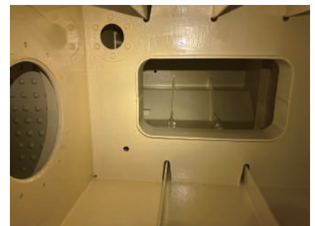
写真 7 PN-01 鋼製基礎内部防食工施工後
