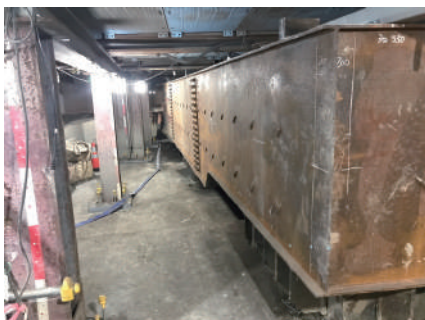
写真 3 PN-01 保護コンクリート撤去後
