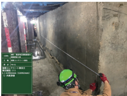
写真 2 PN-01 保護コンクリート撤去前
