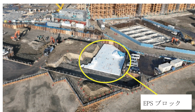
写真14 EPSブロックによるEPS置換基礎工法
