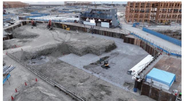
写真11 敷鉄板での山留めの構築状況
