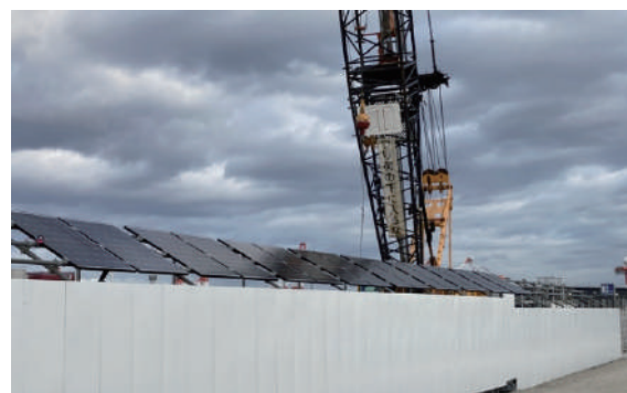
写真7 ソーラーパネルの設置状況
