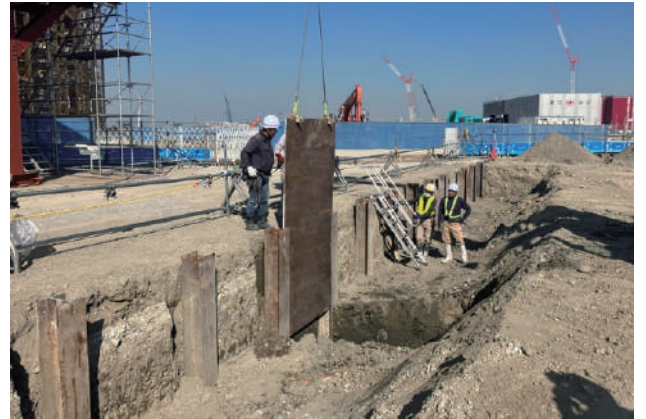
写真10 敷鉄板の設置状況
