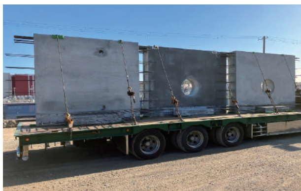
写真12 プレキャスト地中梁の搬入状況
