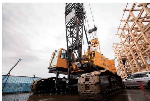
写真6 B100で稼働するクローラークレーン
