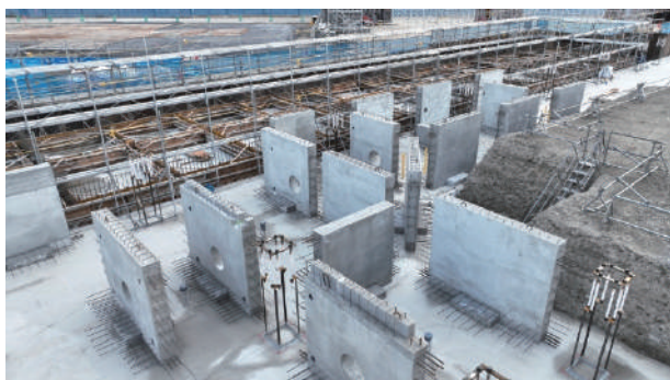
写真13 サポートレスプレキャスト地中梁の据付け状況
