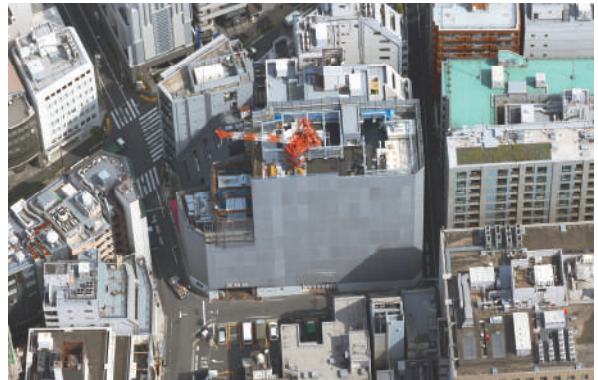
写真 4 後行工区鉄骨建方状況
