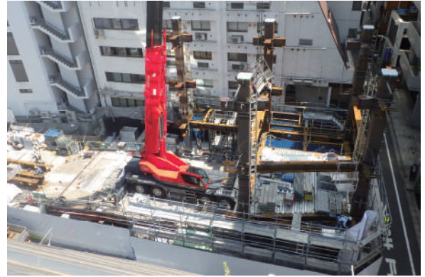
写真 3 先行工区鉄骨建方状況
