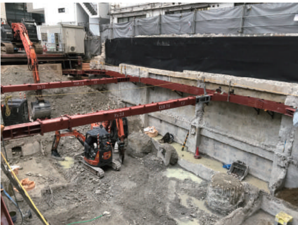
写真 2 既存地下解体状況
