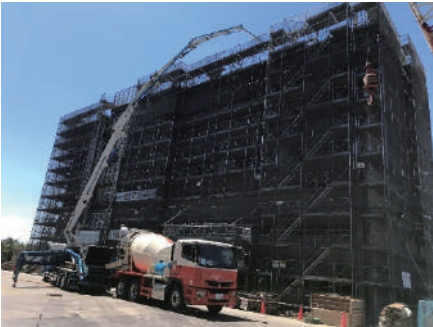
写真 1 現場運用状況
