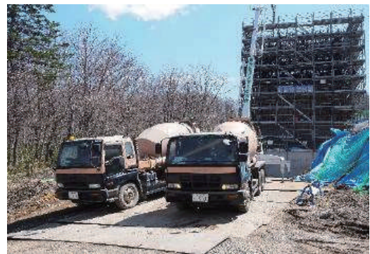
写真 2 現場実証状況
