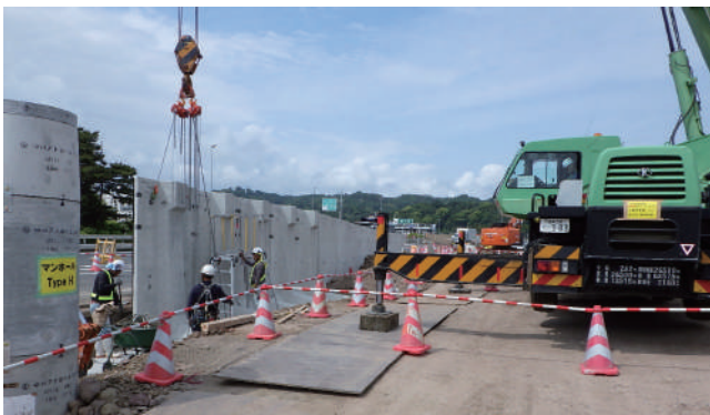
写真7 道路部プレキャスト擁壁据付け状況
