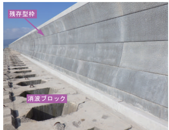
写真 3 残存型枠の設置状況
