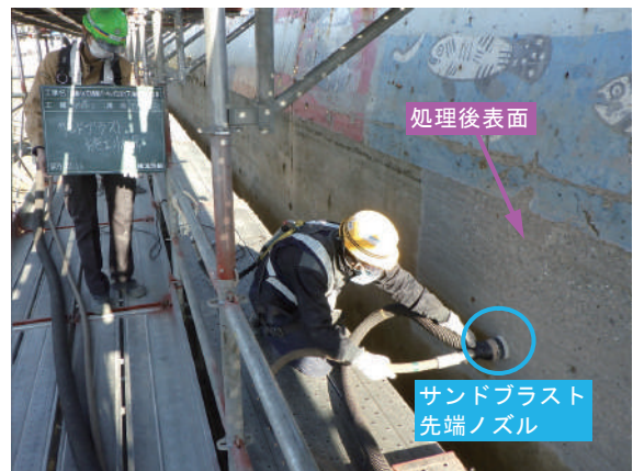
写真 4 既設擁壁表面の処理状況
