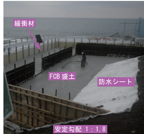
写真 6 FCB 盛土の施工状況
