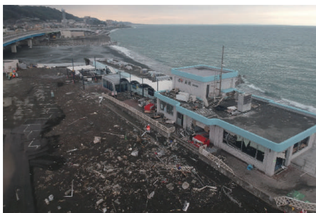
写真2 休憩施設における被災状況 2)
