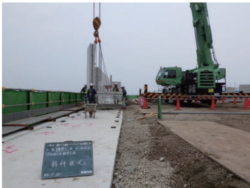
写真 5 L 型擁壁の設置状況
