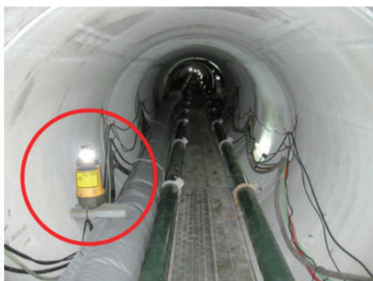
写真4 自動測量機器設置状況
