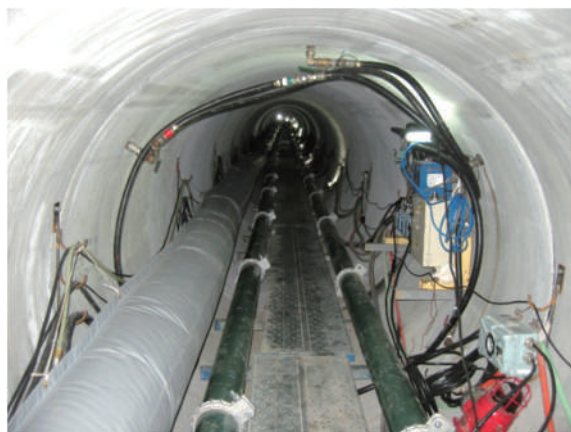
写真3 中間滑材注入装置
