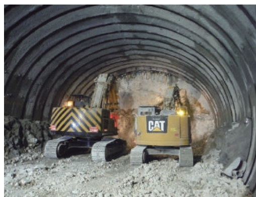
写真3 トンネル掘削状況（旧 JR 隧道交差区間）
