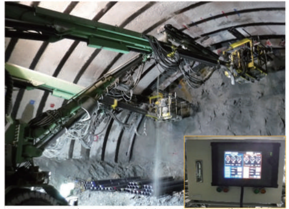
写真4 切羽前方探査実施状況 5)
