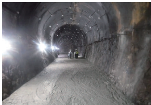
写真2 旧 JR 隧道閉塞工（エアミルク充填状況） 2)
