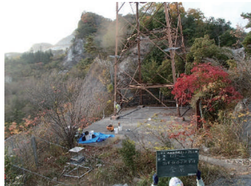
写真5 鉄塔計測計器設置状況
