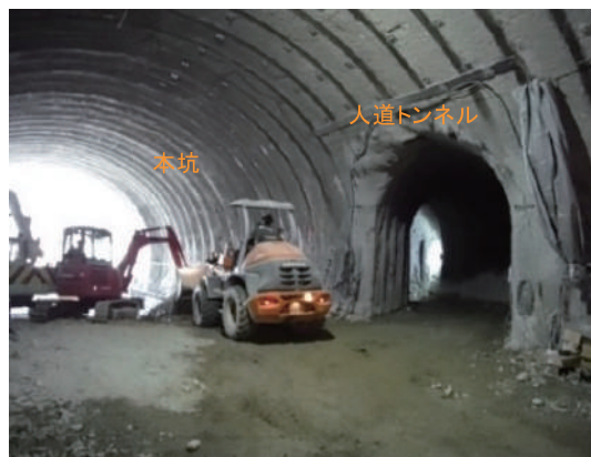
写真6 人道トンネル掘削状況
