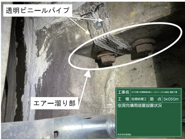
写真7 エアーストリート部注入ホース設置状況
