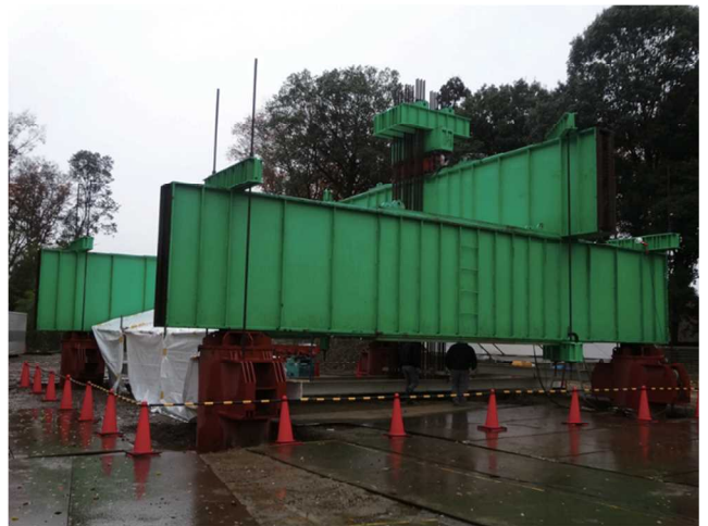
写真1 载荷試験の実施状況
