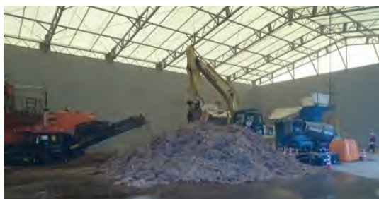
写真2 破碎機と圧縮梱包機による量の中間処理状況
