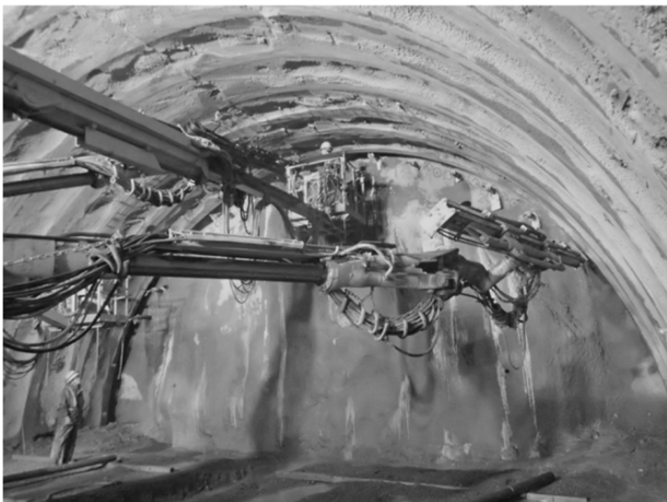
写真6 鋼管打設状況 (AGF 工法)
