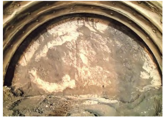
写真3 No. 98+03.0 切羽状況(鉄塔1直下)
