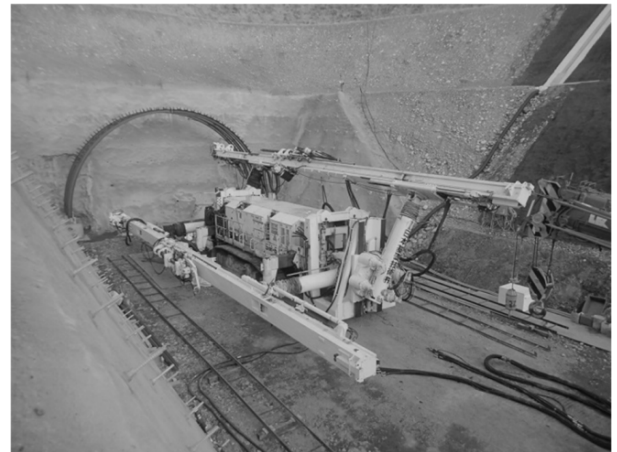
写真4 専用削孔機(トレヴィチューブ工法)
