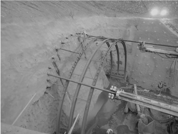
写真5 鋼管削孔状況(トレヴィチューブ工法)
