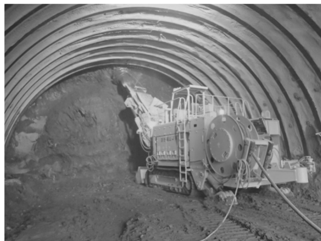
写真1 自由断面掘削機(300kw級 S-300)
