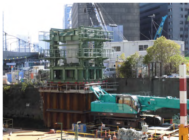
写真3 P2 橋脚 PC ウェル工法の施工状況
