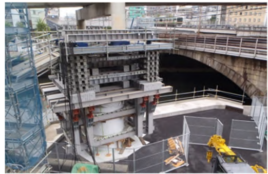
写真 4 P2 橋脚部のベント
