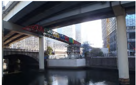
写真 5 首都高直下を通過する手延べ機
