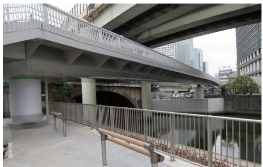
写真 6 架設完了全景
