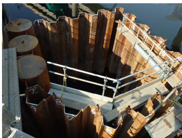
写真2 PC ウェル反力架台
