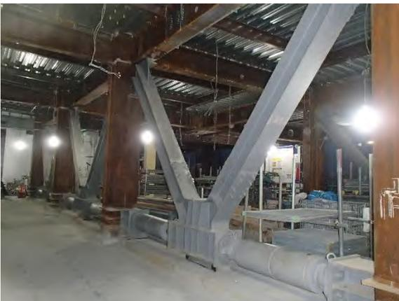
写真1 オイルダンパー設置状況
