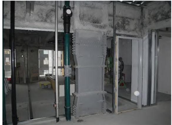
写真2 制振間柱設置状況
