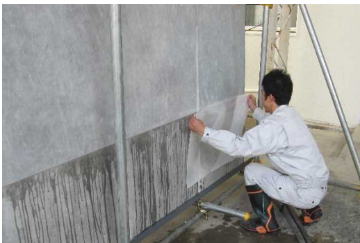
写真3 養生シートの貼り付け状況
