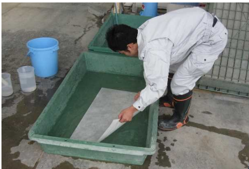
写真2 養生シートの濡らし方の一例
