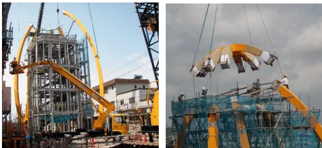
写真7 建方状況（左：鉄骨柱、右：頭頂部）
