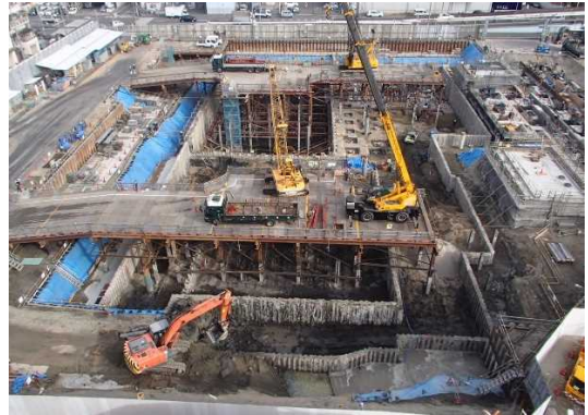
写真2 地下工事の状況
