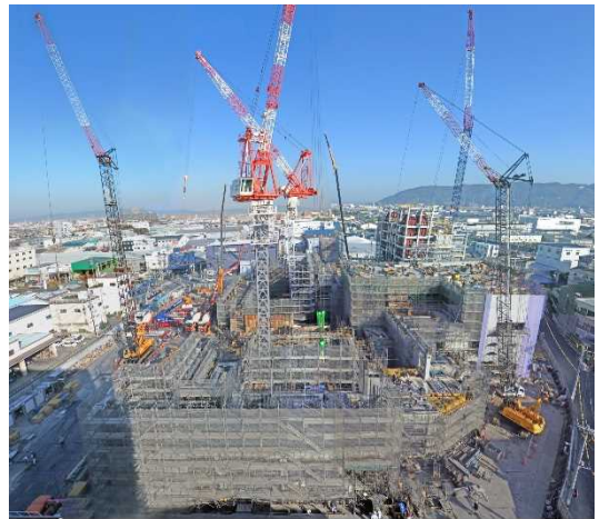
写真3 地上工事の状況
