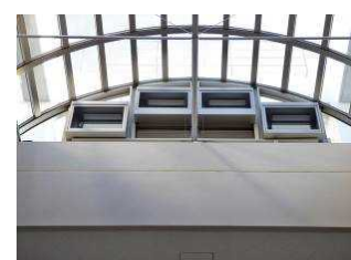
写真 2 自然換気開口
