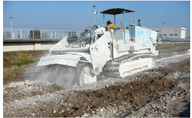
写真2 固化・不溶化処理施工状況
