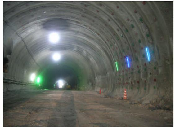
写真8 縫返し箇所に取り付けたLEDS(V.2)<sup>4)</sup>
