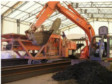
写真1 生石灰混合工程の概要
