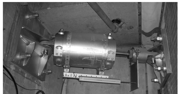
写真2 ダンパー取付状況
