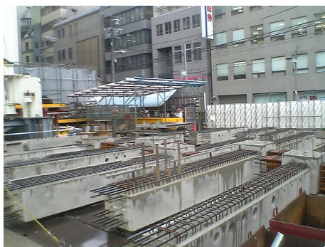
写真 14 梁 PCa のストック状況
