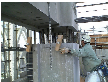
写真6 梁 PCa (パネルゾーン部) 取り付け
