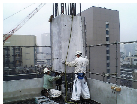
写真10 柱 PCa 取り付け
