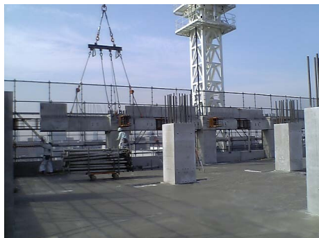
写真5 梁 PCa 取り付け
