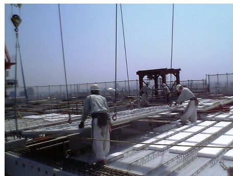
写真9 床 PCa 取り付け
