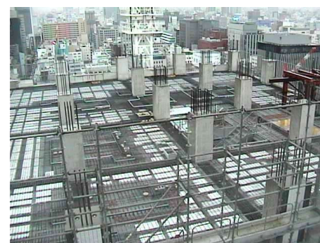
写真12 3日目作業終了時の状況
