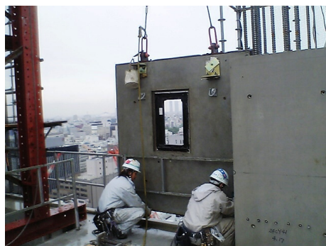
写真7 妻壁 PCa 取り付け
