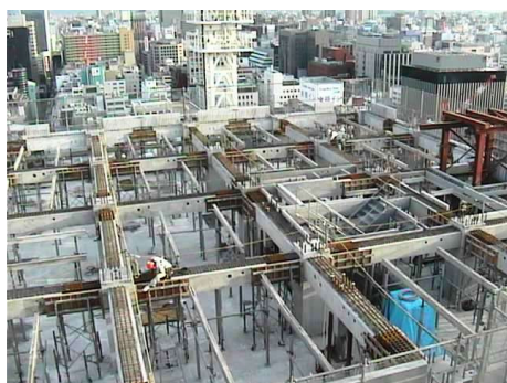
写真8 1日目作業終了時の状況
