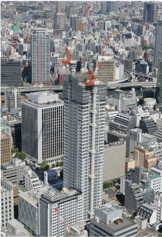
写真1 施工中の建物全景
