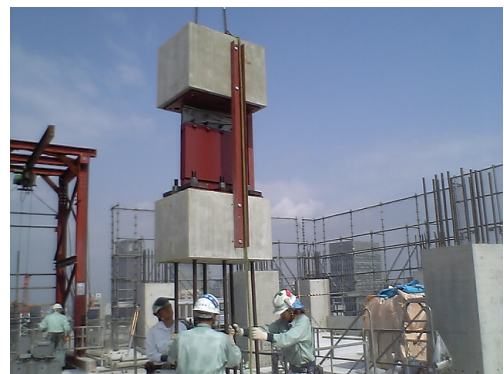
写真2 間柱型粘弾性ダンパー
