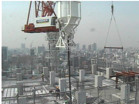
写真 13 バケットによるコンクリート打設
