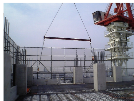
写真11 吊り足場クライミング
