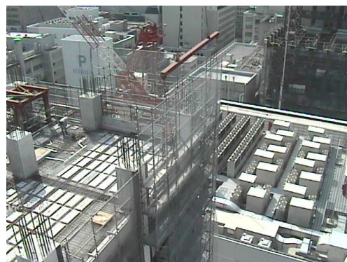
写真4 連層吊り足場のクライミング
