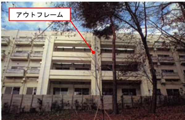
写真2 Y社研修所(C通り側、補強後)
