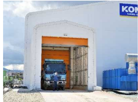
写真 4 インターロック制御二重扉
