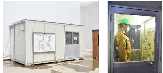
写真 5 エアシャワー付き更衣室
