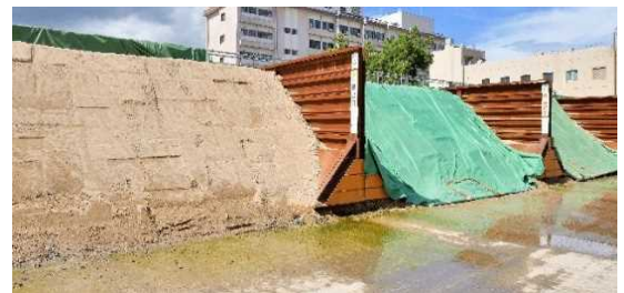
写真 6 洗浄土仮置場
