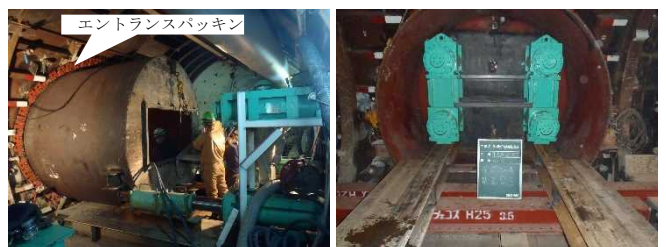
写真2 鋼管刃口推進状況(左)と推進ジャッキ格納状況
