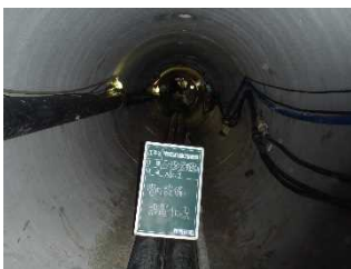
写真6 坑内排泥管
