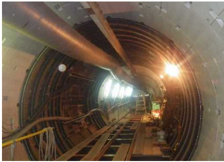
写真3 開口補強施工状況
