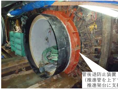
写真 9 管後退防止装置
