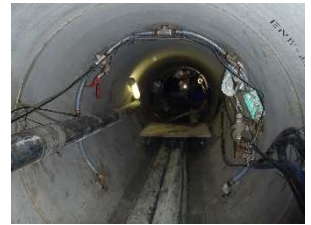
写真10 ES剤注入状況
