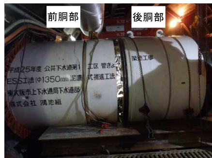
写真8 坑内掘進機組立状況
