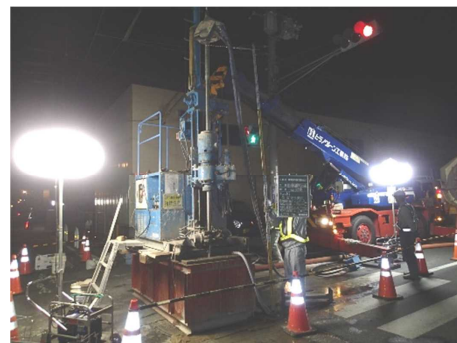
写真4 排泥タンク方式によるJSG施工状況
