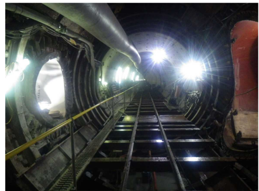
写真11 推進工事完了
