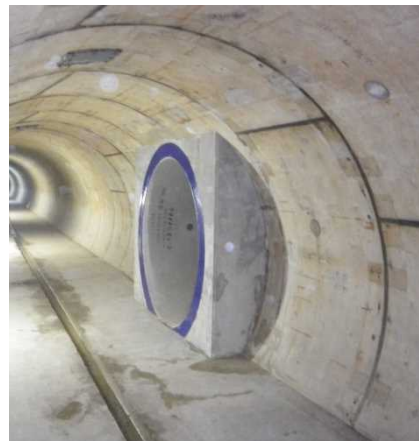
写真 3 既設シールドトンネル側接合部 工事完了
