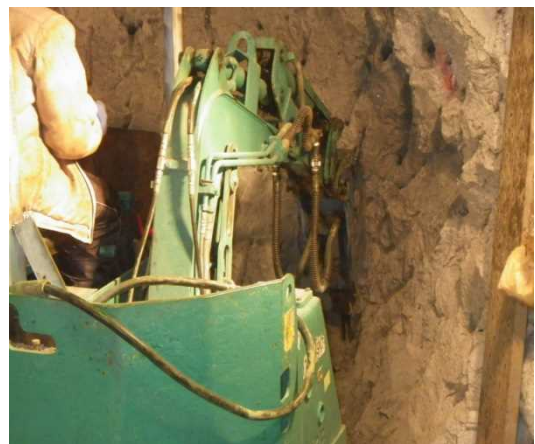
写真2 電動式バックホウによる凍土掘削状況
