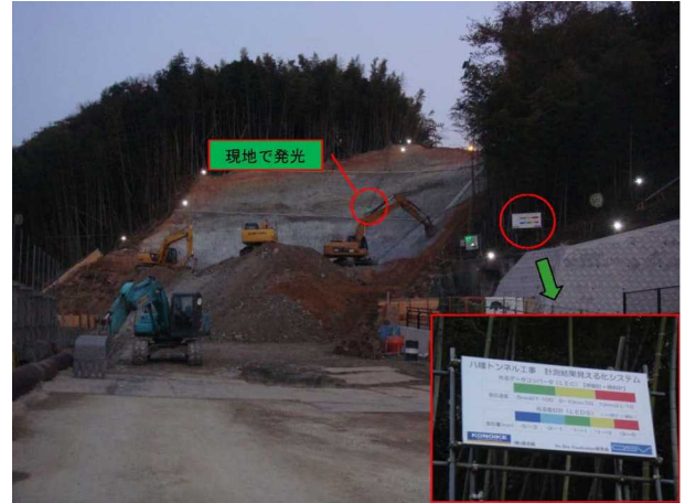
写真5 起点側坑口切土時安全の見える化 1)
