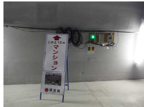
写真13 覆工発生応力の見える化
