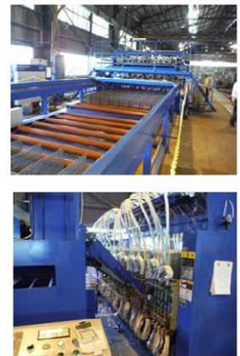
図9 ユニット鉄筋 工場製作状況
