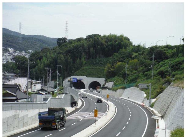
写真 15 トンネル供用状況
