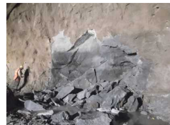
芯抜き状況（ガンサイザー使用）
