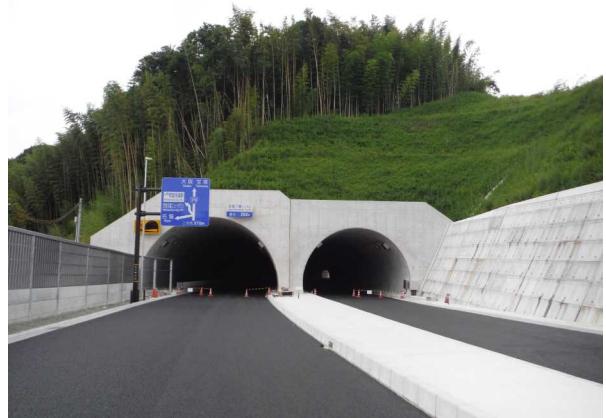
写真 14 トンネル完成写真
