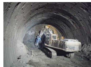
後進坑掘削状況（D I パターン）
