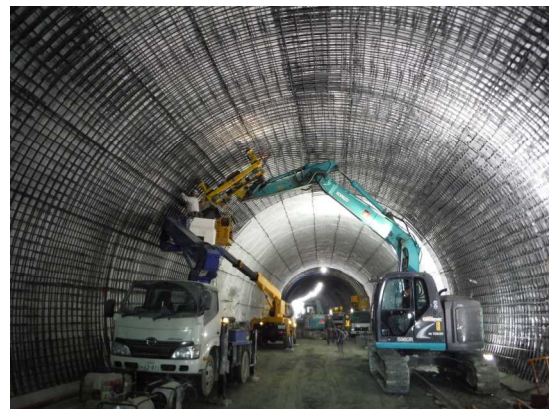
写真11 ユニット鉄筋 現場組立状況
