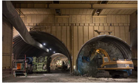
写真1 上下線併進状況
