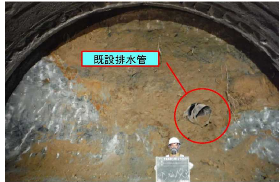
写真10 既設排水管出現状況 3)
