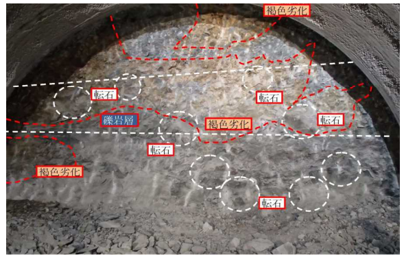
写真2 切羽状況(上り線沢部通過時)
