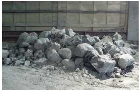
写真3 硬質玉石(上り線沢部通過時)
