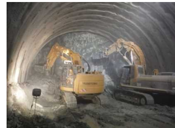
先進坑掘削状況（D I パターン）
