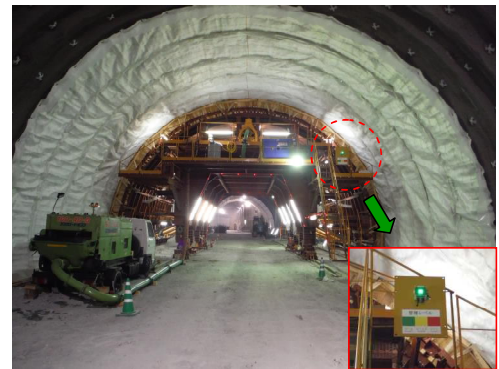
写真12 FRP セントルと圧力管理の見える化
