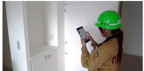
写真2 仕上げ検査状況
