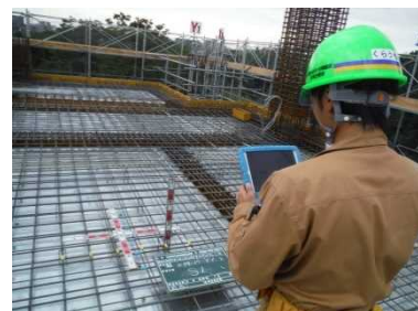
写真1 配筋検査状況
