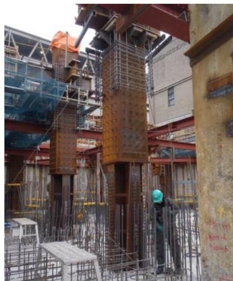
写真5 耐圧版上の鉄骨建方
