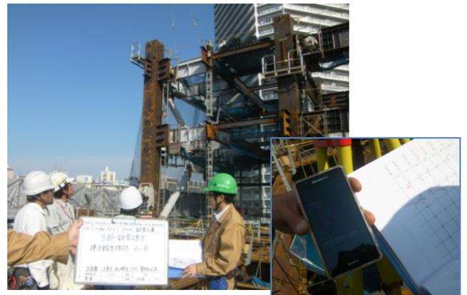
写真11 鉄骨建方精度管理システム
