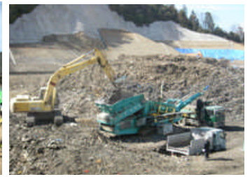
写真 2 分別状況(振動スクリーン)
