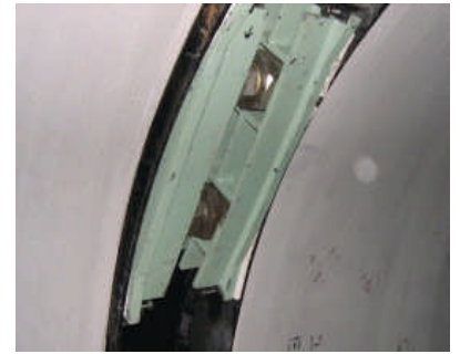
写真6 開口調整装置(UCS)設置状況
