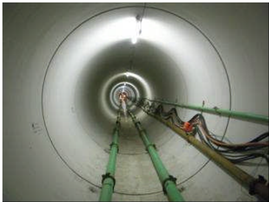
写真 14 推進工管内状況
