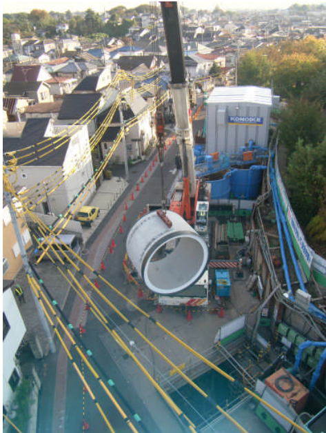
写真1 発進基地全景
