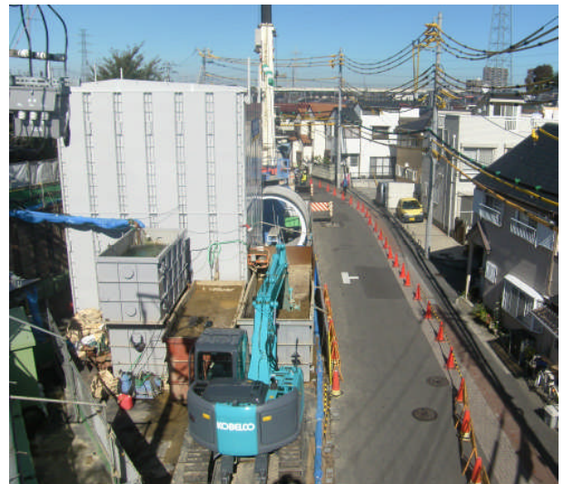
写真11 騒音対策実施状況 (防音ハウス、極低騒音型バックホウ)
