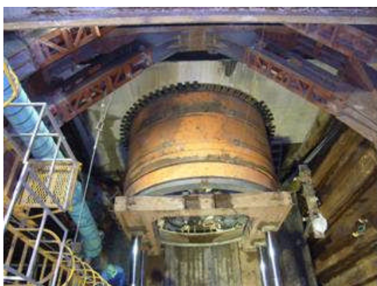
写真 13 初期掘進状況（上段管施工時）
