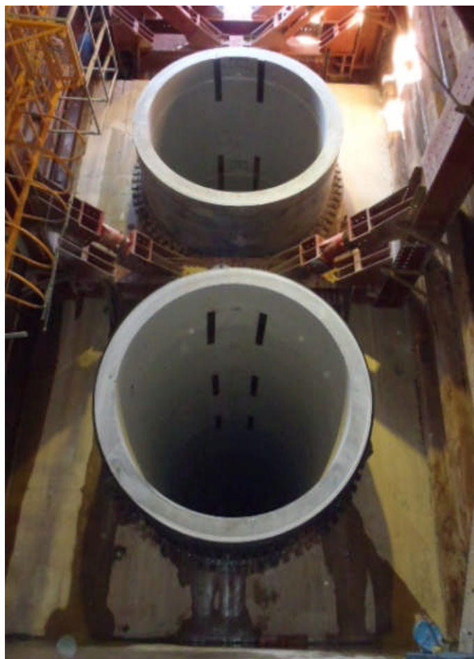
写真 16 上下2段推進管敷設完了
