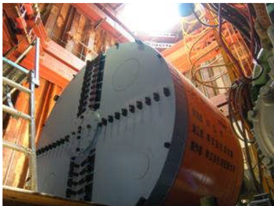
写真 12 掘進機設置状況（下段管施工時）
