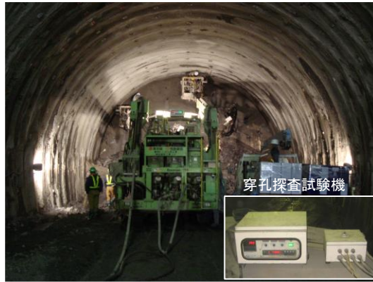
写真-1 切羽における前方探査実施状況
