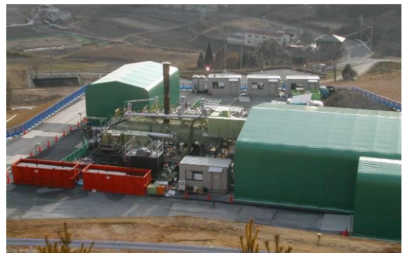
TPS工法 設備設置状況
