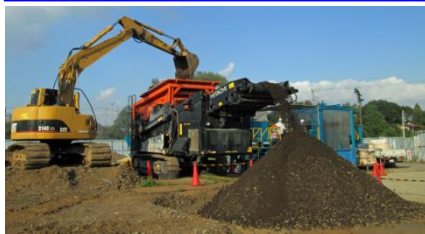
③建設発生土混入廃棄物二次選別状況 (40mmアンダー材)
