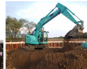
⑤CW混合攪拌状況 (100mmアンダー材に添加)
