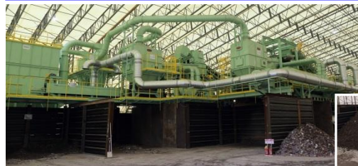
④選別処理施設(各種スクリーン、磁力・風力・人力選別) (選別土、選別再生資材、選別除去廃棄物に分別を実施)
