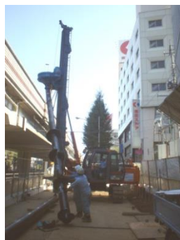
歩道橋新設工事：代田橋駅前
