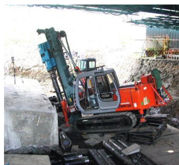
耐震補強工事：柏尾川大橋（旧橋）
