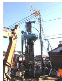
橋梁新設工事：新田橋
