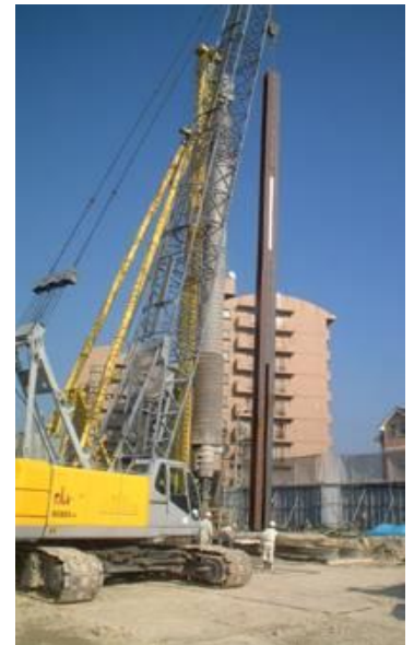
通水ボックス建込み状況
