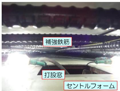
写真-2 トンネル天端打設空間
