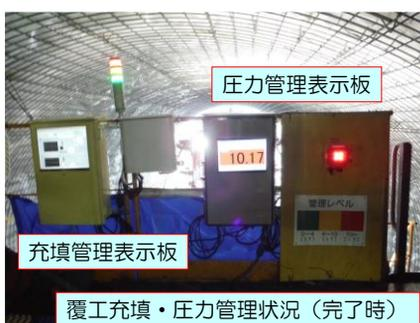
写真-5 充填・圧力表示板
