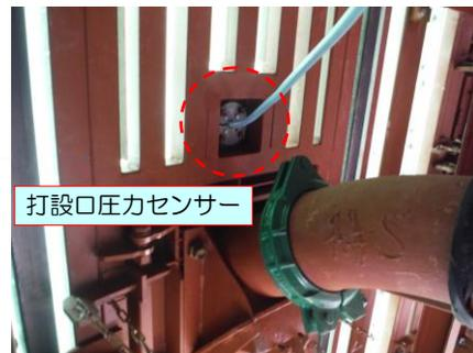
写真-3 打設口圧力センサー
