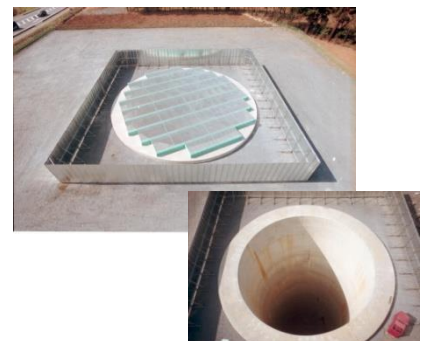
立坑完成状況
