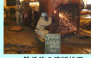
除染後の溶断状況
