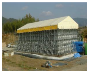
橋本市産廃焼却施設解体
