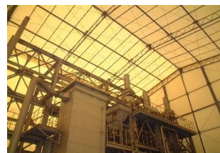
B社（大阪市）焼却施設解体
