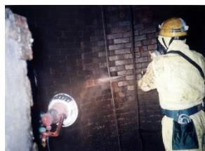
広島県熊野町焼却施設解体
