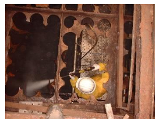
A社（横浜市）焼却施設解体
